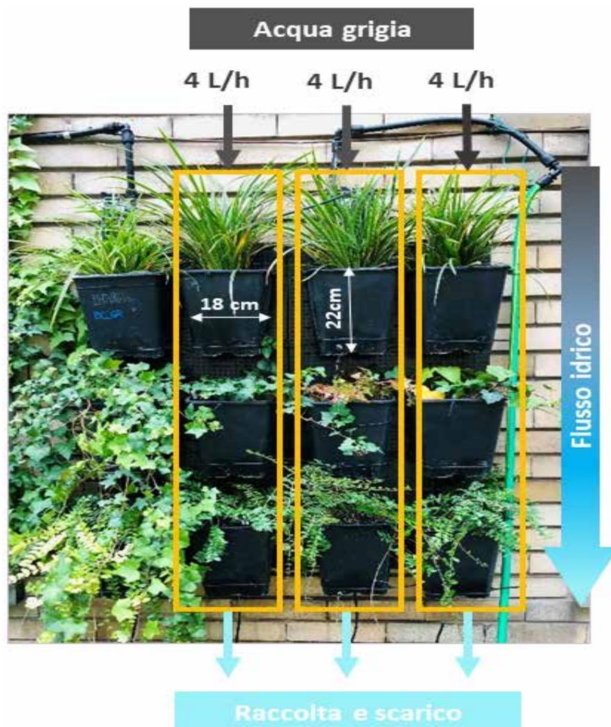
Fig. 1 – Struttura e schema di funzionamento di un pannello modulare.
